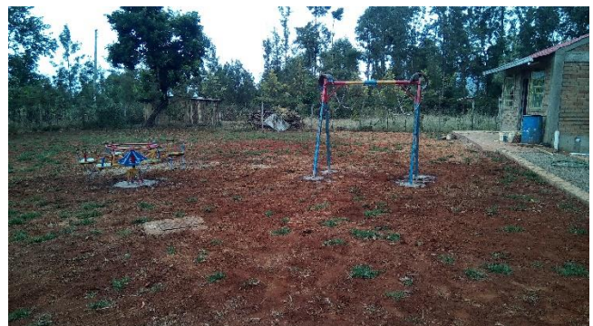
die neuen Spielgeräte sind einbetoniert...
